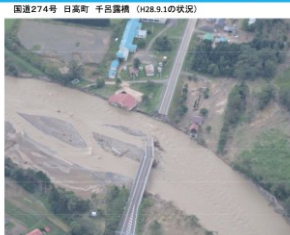
⑤国道274号 日高町千巻～湯元町清水 (L=43.8km) 区間の主な被災状況
